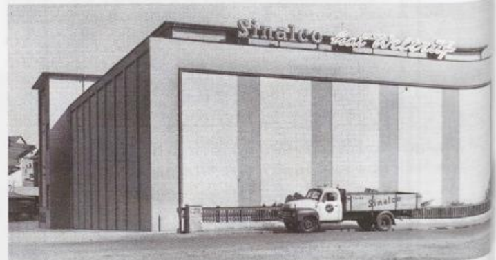
Abb. 5.21 a) Sinalco-Vertrag mit Gebäudekomplex (Sammlung: Dirk Beckmann) b) Sinalco-Kühlhaus am Bahnhof (Sammlung: Dirk Beckmann)
