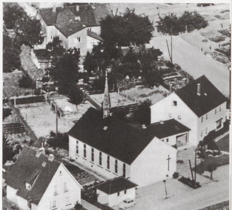
Abb. 19.1 Die Pauluskirche. Der Kirchturm steht noch auf der Gebäuderückseite.
