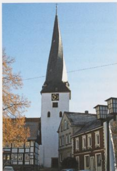
Abb. 9.1 Kirche in Heiden. Ausgrabungen im Jahr 1970 ergaben, dass der heutigen Kirche vier ältere Kirchbauten vorausgingen. Die Restaurierung der Trockenmauer im Jahr 2013 förderte einen 700 Jahre alten Taufstein zu Tage.
