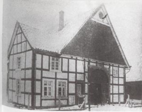
Abb. 14.1 Die Nr. 23 errichtet 1822. Hier wohnte Adolf Heistermann. 1909/10 kaufte Friedrich Böke das Haus (Schmiede Böke, Foto: Fritz Böke).
