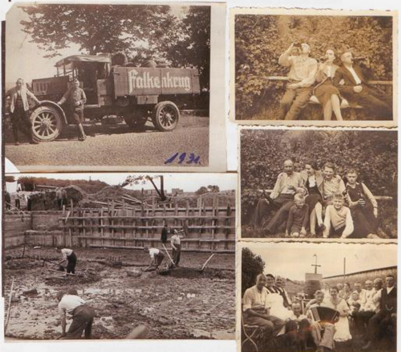
Abb. 5.19 oben li.: Erich Diekmann, Kraftfahrer bei der Brauerei „Falkenkrug“. Li. unten: Ausschachtarbeiten für das Freibad in Detmold. Re.: Früher wie heute, Bier darf aus der Flasche getrunken werden. (Fotos: Ilse Hilmert).
